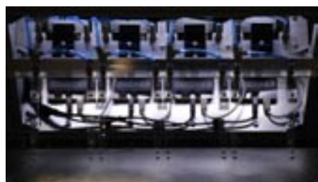
Obr. 3: Rozvody stlačeného vzduchu pro pneumatické písty
